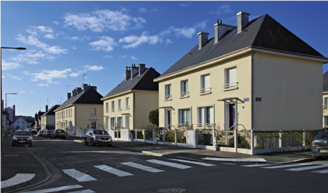
Résidence Bords de Cher - TOURS travaux de réhabilitation
