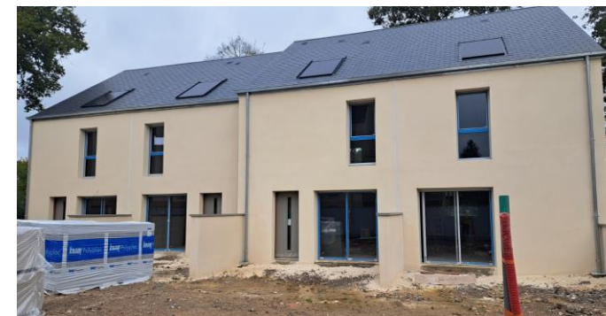
Les pavillons St Martin
