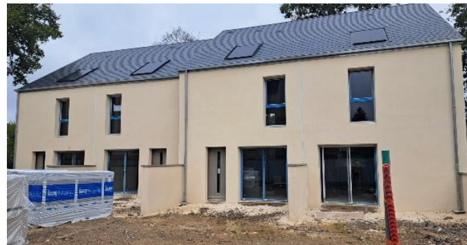
Les pavillons St Martin
