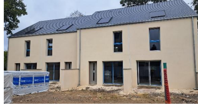
Les pavillons St Martin
